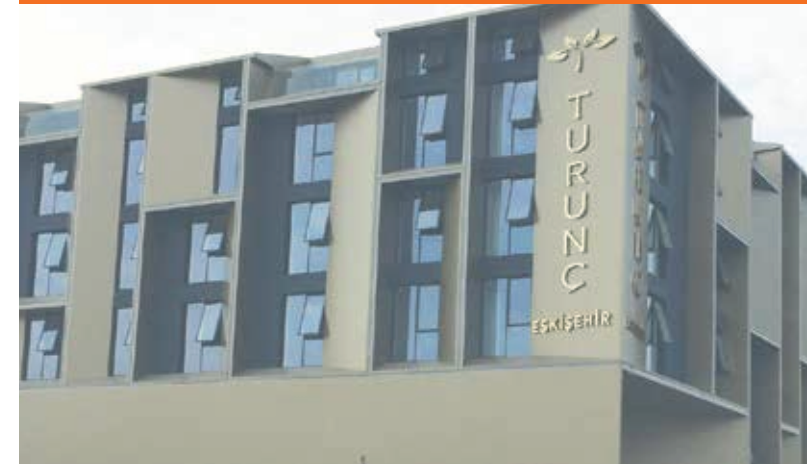
Turunç Otel Eskişehir
